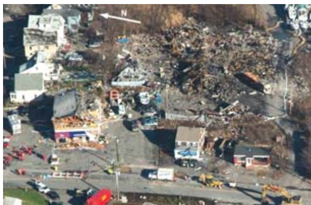
Место происшествия на территории предприятий CAI и Arnel Manufacturing Facility (г. Дэнверс штата Массачусетс США)
