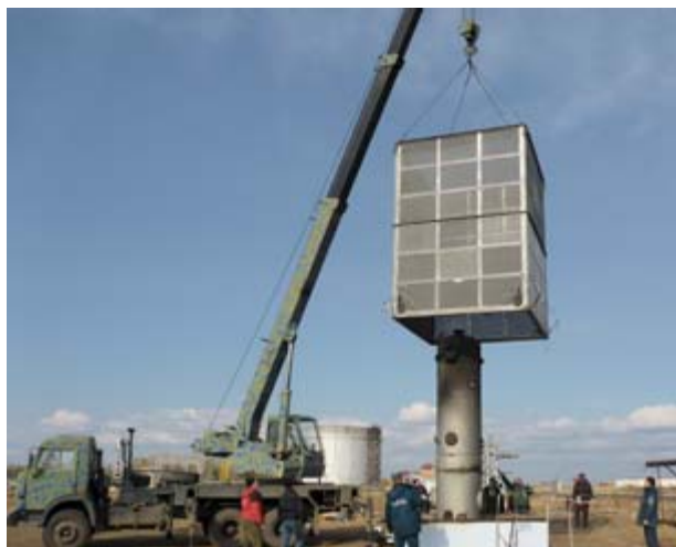
Рис. 2. Монтаж стенда для исследования теплозащитных экранов
