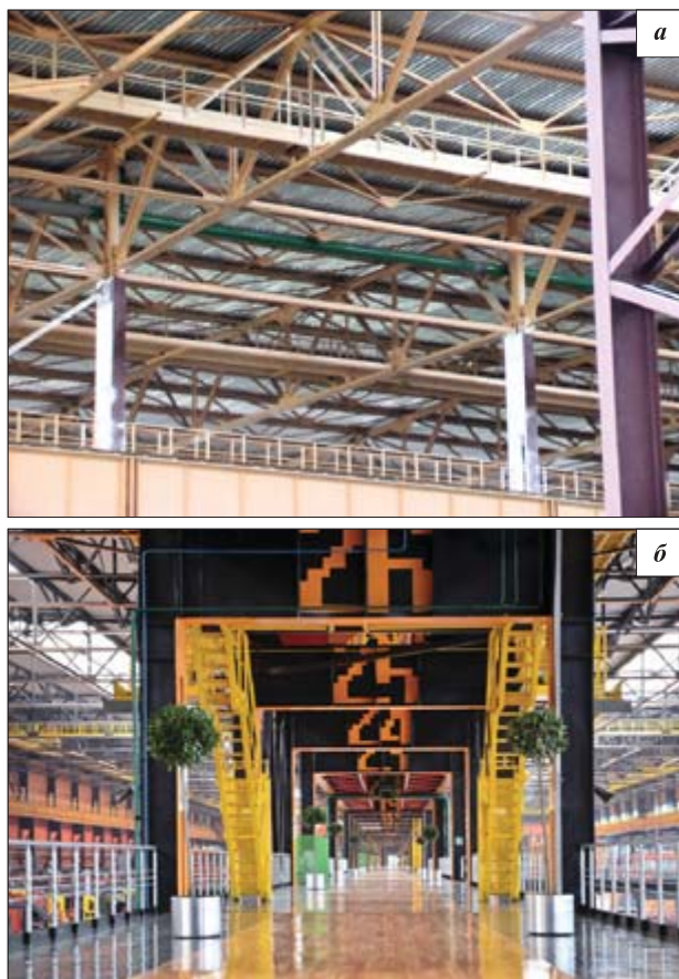
Рис. 3. Пентафталевая эмаль на огнезащитном покрытии “Терма®” (сертифицированная система): а — ЗАО “Ижорский трубный завод”, площадь огнезащиты более 30 тыс. м 2 ; б — ОАО “Челябинский трубопрокатный завод”, площадь огнезащиты более 50 тыс. м 2
