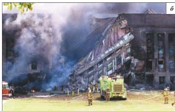
Рис. 3. Наружное кольцо здания Пентагона в зоне СНЕ IEF во время событий 11 сентября 2001 г. до прогрессирующего обрушения (а) и после него (б)
