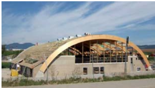
Рис. 1. Объект в начале строительства
