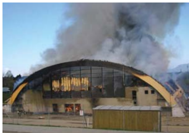
Рис. 4. Тушение локальных очагов внутри постройки [2]
