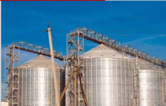
Пенополиуретановая теплоизоляция резервуаров
