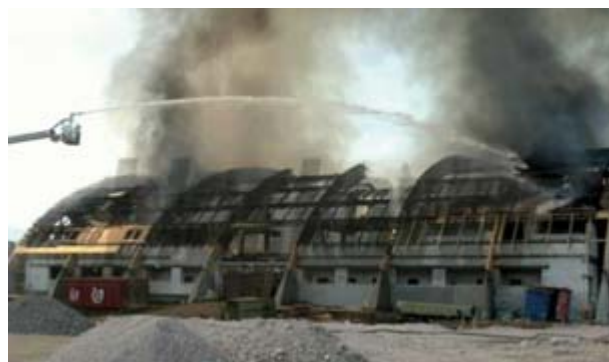
Рис. 5. Последняя фаза тушения пожара в многофункциональном объекте [2]
