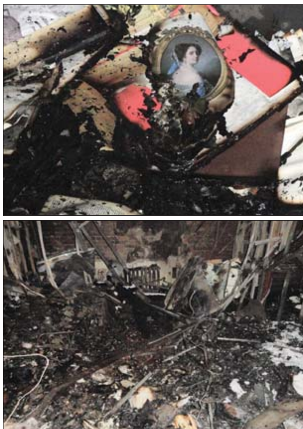
Рис. 2. Обгоревшие кипы фотобумаги на полу чердака в эпицентре пожара
