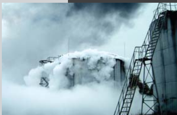
Тушение пожаров в резервуарах с нефтью
