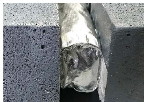
Рис. 5. Огнестойкая заделка деформационного шва изделием “ПРОМИЗОЛ-Шов-Ш150/240-80”
