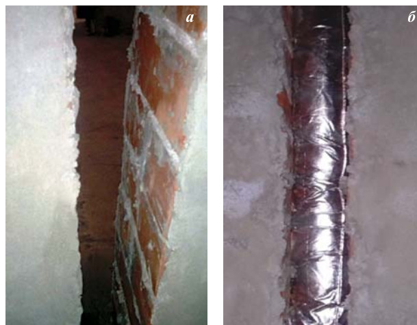
Рис. 1. Деформационный шов без огнестойкого заполнения (а) и с огнестойким заполнением (б)
