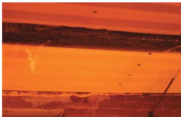
Рис. 6. Фрагмент образца деревянной балки во время огневых испытаний
