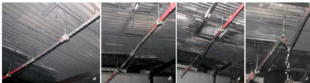
Рис. 11. Состояние труб после различных режимов испытания; а — труба покрыта слоем гари; б — труба имеет мелкие прорывы; в — разрыв трубы; г — труба частично расплавилась и разрушилась
