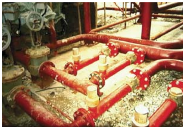
Рис. 10. Высоконапорные генераторы низкой производительности, соединенные попарно на один линейный ввод пены
