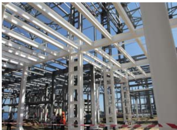
Рис. 8. Система покрытий ГФ-021 + ВУП-2 + ПФ-115 (Саратовская обл., пос. Юбилейный, Сельхозрынок, эксплуатация 6 лет)
