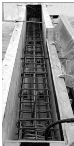
Рис. 1. Арматурный каркас опытного образца балки перед бетонированием (по технологии итальянской фирмы): в опалубочную форму установлены продольные и поперечные стержни ненапрягаемой арматуры, а также каналообразователь с протянутыми арматурными канатами при использовании технологии постнапряжения
