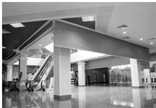
Рис. 22. Применение спринклеров в сочетании с противопожарной шторой
