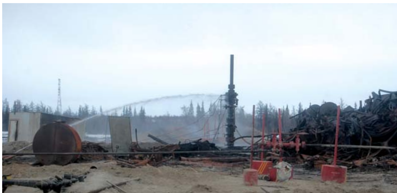
Рис. 5. Глушение фонтанирующей скважины при постоянном орошении ее устья
