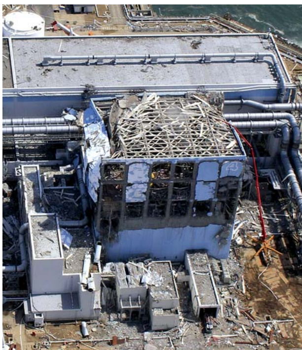
Рис. 1. Оболочка реактора на АЭС “Фукусима” после взрыва водорода
