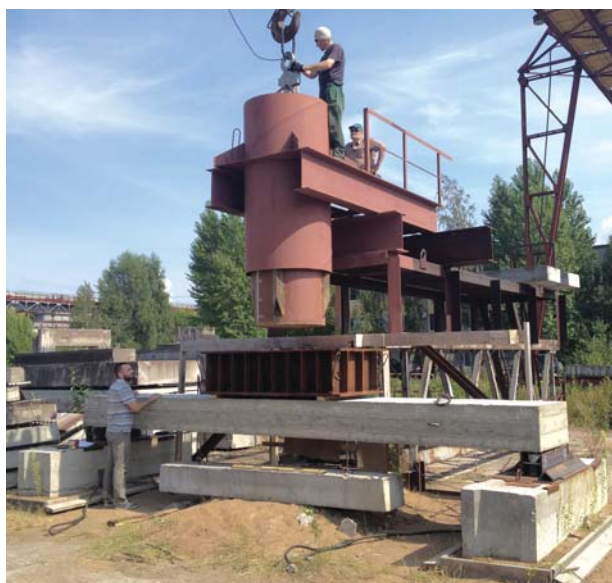
Рис. 5. Копровой стэнд для динамических испытаний
