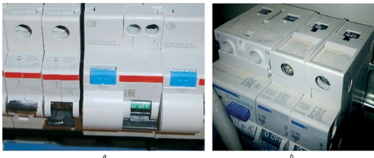
Рис. 1. Накопление пыли во внутреннем пространстве электрических щитов на аппаратах защиты
