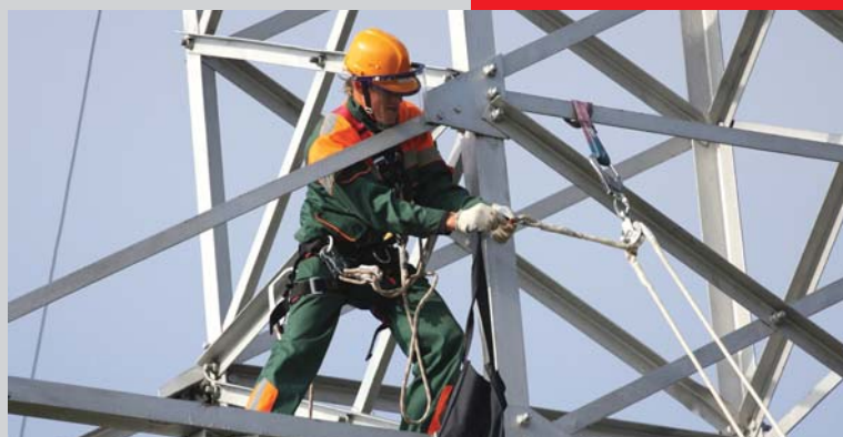
Безопасность работ на высоте опор ВЛС и ВЛЭ
