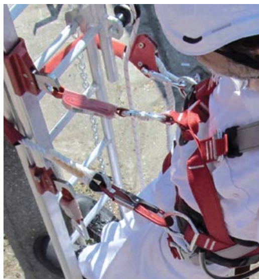
Рис. 6. Применение жесткой анкерной линии / Fig. 6. Apply a rigid anchor line
