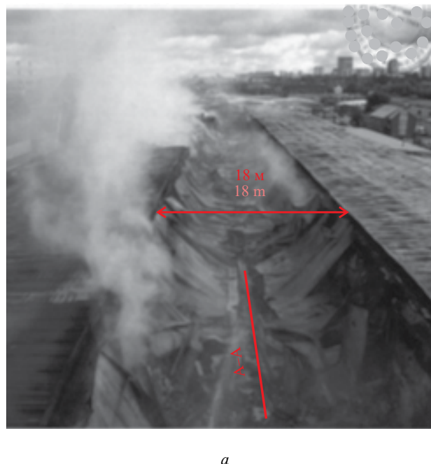
Рис. 1. Обрушение кровли склада при аварийном «хлопке», происшедшем при ликвидации пожара: a — фотография зоны обрушения кровли; b — план здания с указанием области обрушения кровли
