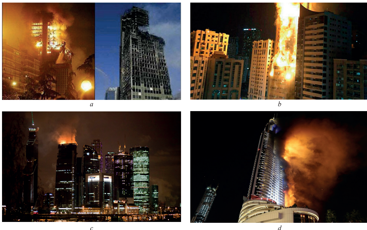
Рис. 1. Пожары в высотных зданиях: a — Мадрид; b — Абу-Даби; c — Москва; d — Дубай
