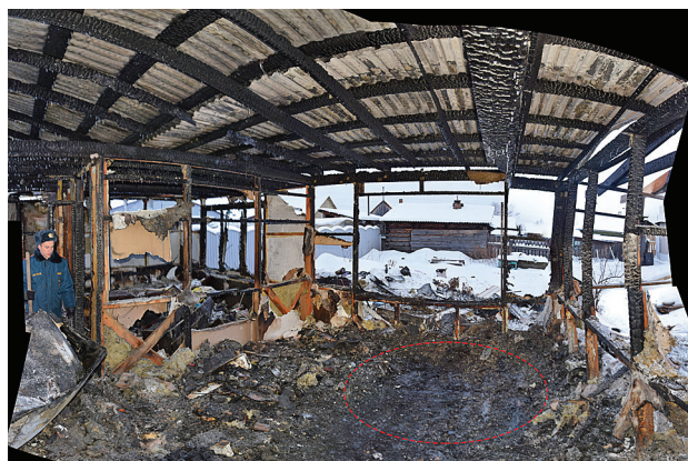
Рис. 8. Панорамный снимок внутреннего объема помещения кухни (овалом обозначен прогар в полу)
