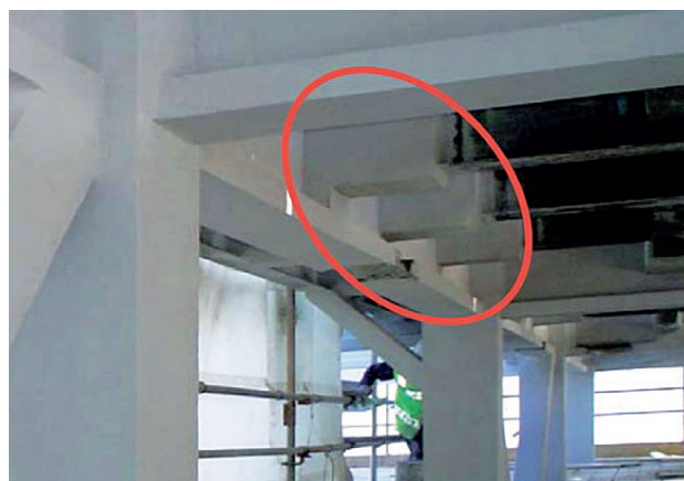
Рис. 1. Пример нанесения огнезащиты Promat на ВСК
