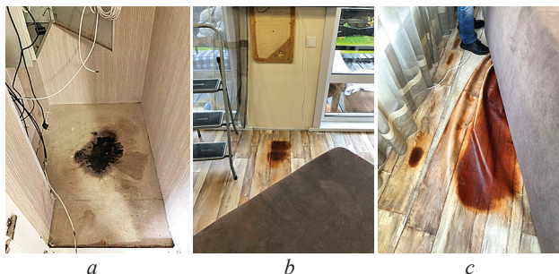
Рис. 16. Места повреждения линолеума в помещениях: a — коридор; b — веранда; c — спальня
