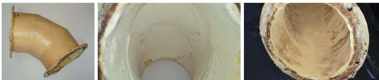
**Рис. 1.** Процесс очистки перегиба трубопровода системы местных отсосов оборудования по обработке полимерных материалов АО «Концерн «Созвездие»» (отвод 45°, D190)
