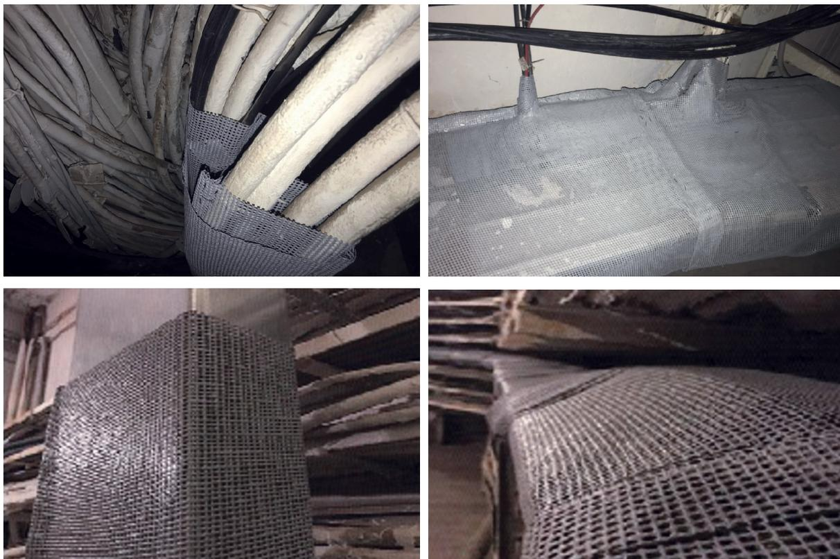
**Рис. 11.** Монтаж огнезащитной сетки на кабельный поток и кабельный короб
