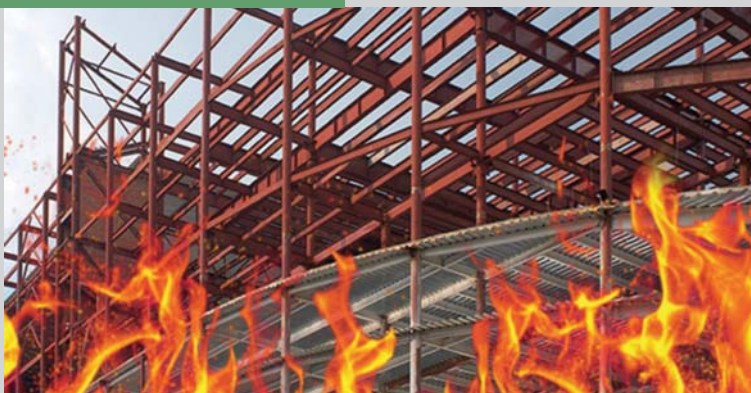
Предел огнестойкости незащищенных стальных конструкций
