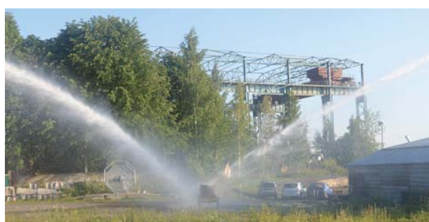
19:24 Конец тушения / 19:24 End of extinguishing
