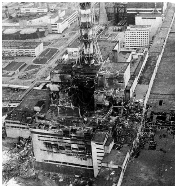
Рис. 1. Последствия взрыва и пожара на Чернобыльской АЭС
