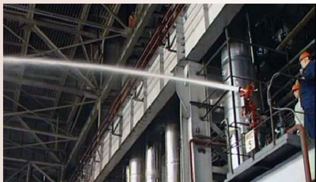
Пожарный робот орошает перекрытия машинного зала ТЭЦ
