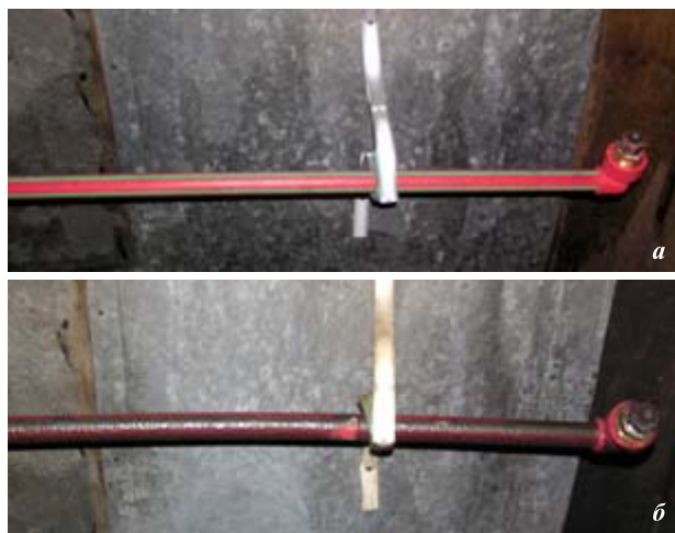
Рис. 4. Состояние трубы диаметром 32 мм до (а) и после (б) испытаний при максимальной температуре пожара 360–500 °С
