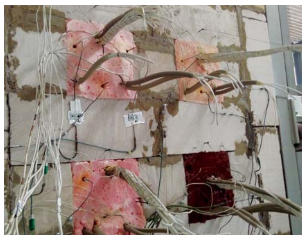
Рис. 3. Общий вид образцов кабельных проходок с необогреваемой стороны перед проведением испытаний
