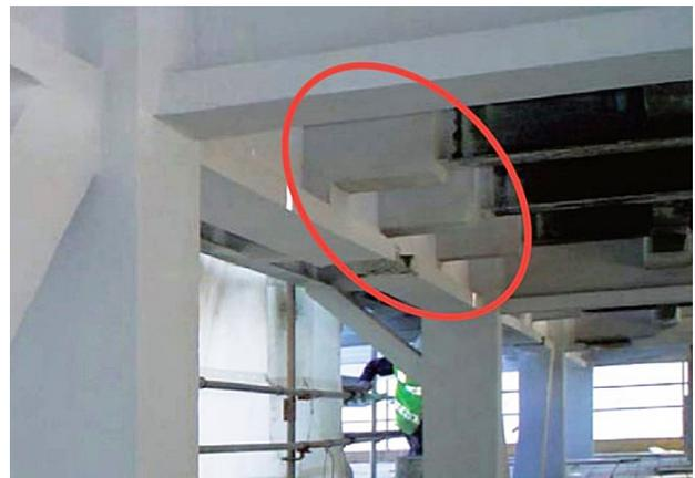
Рис. 1. Пример нанесения огнезащиты Promat на ВСК
