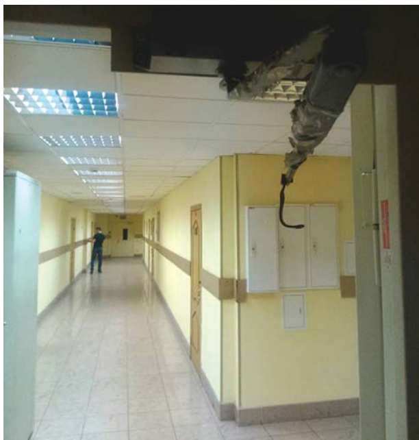
Рис. 4. Разобранное устройство для самозакрывания двери лестничной клетки
