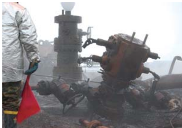
Рис. 3. Демонтаж трубной головки
