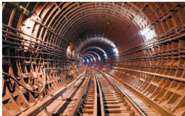
Рис. 1. Тоннель Московского метро Fig. 1. Moscow Metro Tunnel
