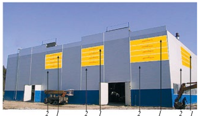
Рис. 11, с. Примерный дизайн установки легкобрасываемых сэндвич-панелей на производственном здании категории А или Б: 1 — смонтированные легкобрасываемые сэндвич-панели (ЛССП); 2 — стеновые сэндвич-панели
