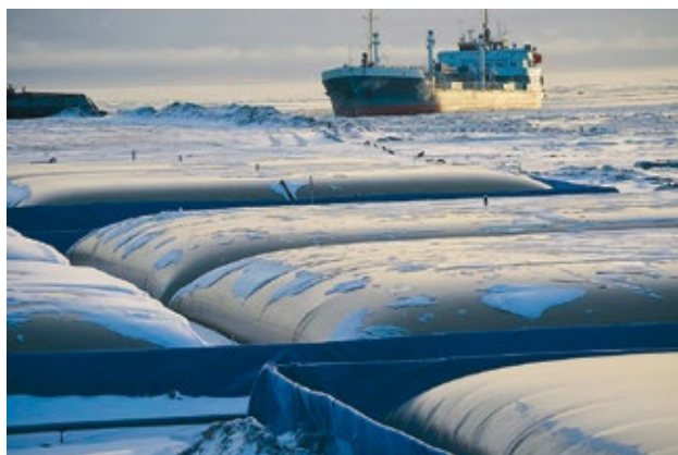
Рис. 1. Склад нефтепродуктов в арктической зоне Fig. 1. Petroleum products warehouse in the Arctic zone
