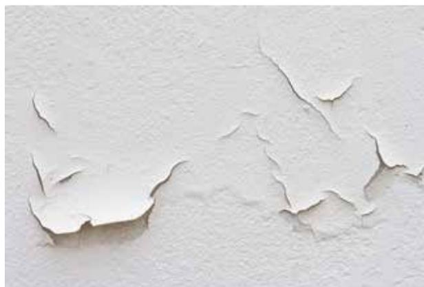
**Рис. 7.** Отслаивание лакокрасочного покрытия в процессе естественного старения
