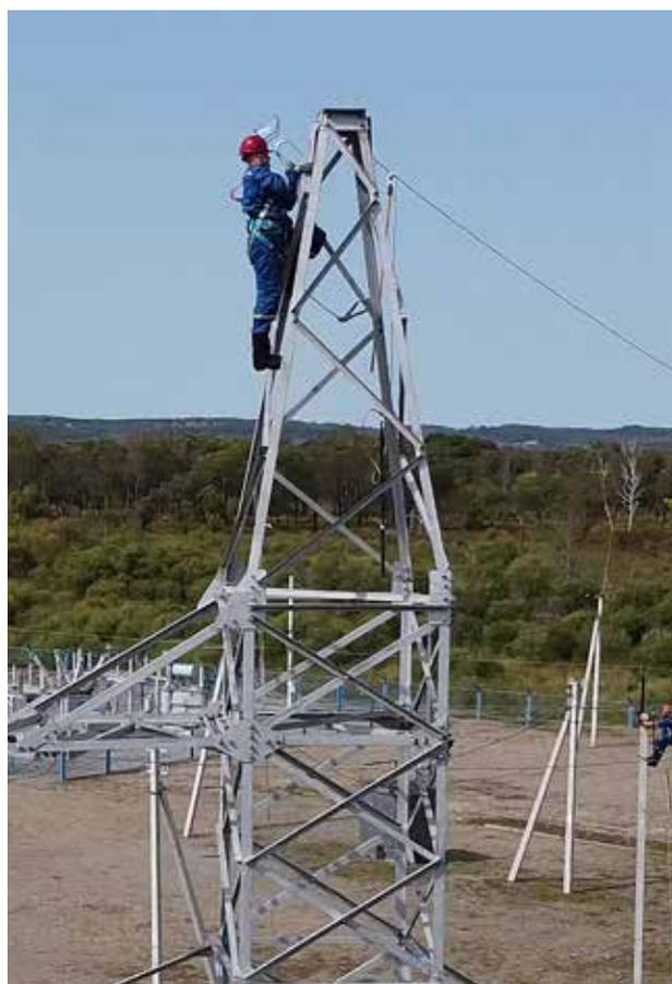
**Рис. 3.** Пример использования текстильных СИЗ от падения с высоты в условиях воздействия светопогоды
