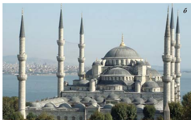
Рис. 2. Церковь Вознесения в Коломенском (а) и Голубая мечеть или Мечеть Султанахмет ( Sultanahmet Camii ) в Стамбуле — выдающийся образец исламской и мировой архитектуры (строительство 1609–1616 гг., вместимость около 10 тыс. чел.) (б)
