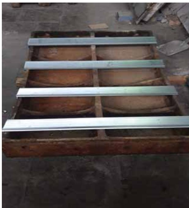
**Рис. 2.** Установка профилей каркаса для монтажа огнезащитных плит
