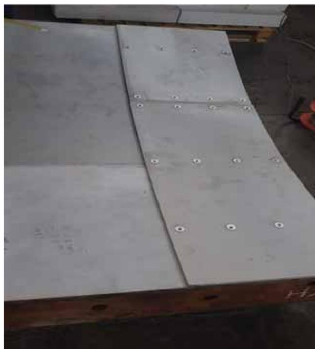
**Рис. 3.** Огнезащитные плиты смонтированы на чугунном тубинге
